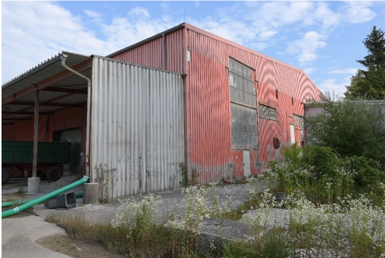
Abb.5: Industriehalle mit potenziellen Fledermausquartieren (Foto: Jungwirth).
