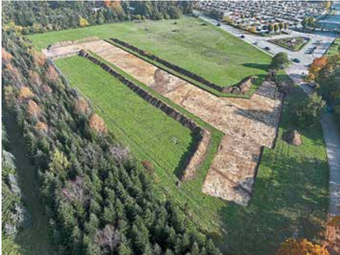
Technologiepark-Ost: Der künftige Straßenverlauf wird ausgebaggert – der Humus wurde bereits abgetragen. (Foto: Markt Manching)
