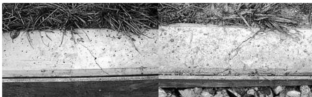
Durchgehender Riss im auszutauschenden Teil der Winkelstützmauer.
