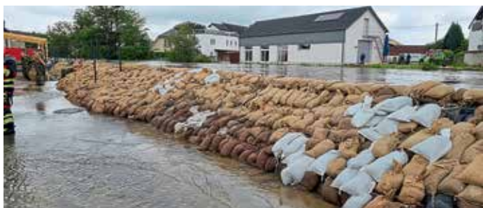
Sandsäcke verhinderten, dass die Wassermassen die Paarstraße (Blick Richtung Trachtenheim) und Schulstraße überfluteten.
