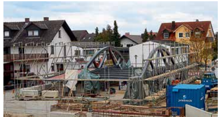
2. Paarbrücke in Schweißposition
