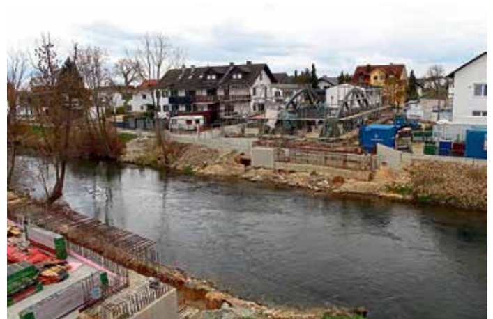
Vorbereitung der 2. Paarbrücke zum Brückenschlag (Einhebung)
