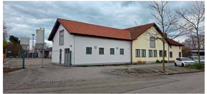
Bauhof: Anbau (links) von Sozialräumen und Lager
