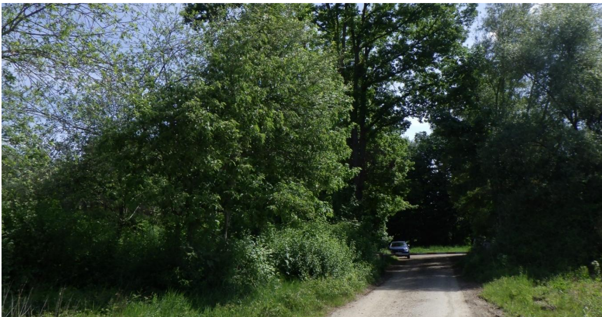
Abb. 8. Bestehende Kieswerkzufahrt mit Anbindung Leilachstraße
