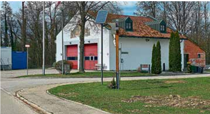
Feuerwehrhaus Oberstimm, Beginn Anbau Rohbau ca. Juni 2026
