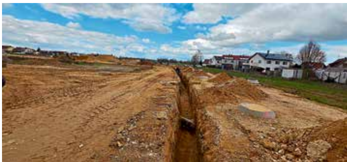
Neues Baugebiet Pichl-West II: Erschließungsarbeiten (Kanal, Wasser) Straßenbau fertig Ende 2026
