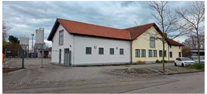
Bauhof: Anbau (links) von Sozialräumen und Lager
