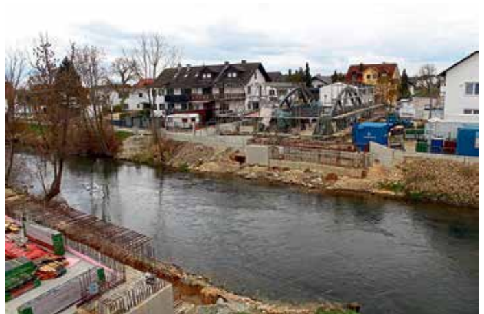
Vorbereitung der 2. Paarbrücke zum Brückenschlag (Einhebung)
