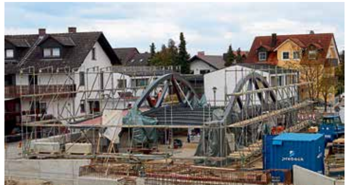
2. Paarbrücke in Schweißposition
